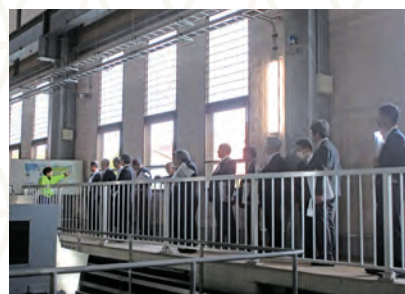
⑦ 両総用水第1揚水機場
