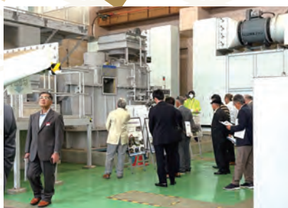
② 大和田排水機場
